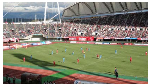
写真1 熊本県民総合運動公園陸上競技場
