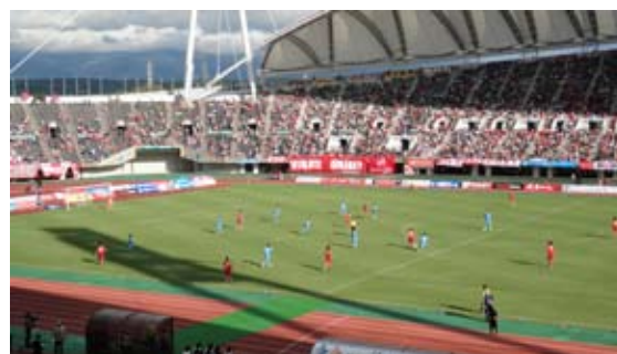
写真1 熊本県民総合運動公園陸上競技場
