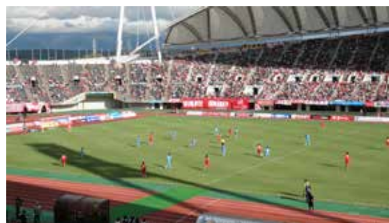
写真1 熊本県民総合運動公園陸上競技場
