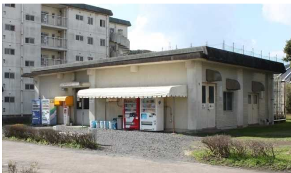
共用棟（管理人室）
