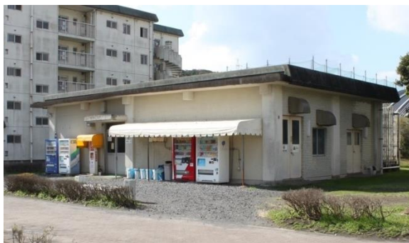
共用棟（管理人室）
