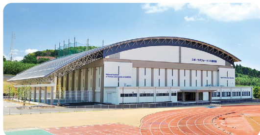
⑪ スポーツパフォーマンス研究センター 本学が推進するスポーツパフォーマンス研究の拠点施設であり、世界で唯一の設備(50mフォースプレート)を備えた屋内研究施設です。
